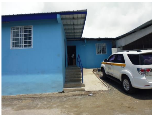
Estructura de la nueva Fachada del CAIPI
